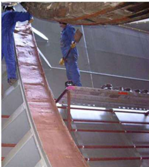
図6 ペースト型のサドルへの塗布
