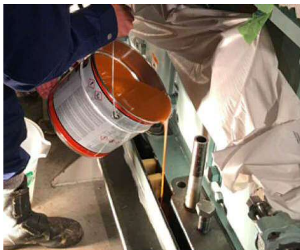
図 1 主機関へのエポキシ樹脂流し込み
