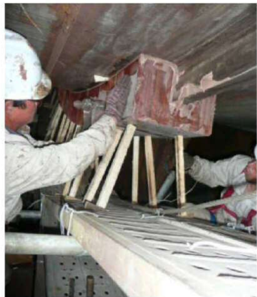
図7 ペースト型によるプレスウッドの固定
